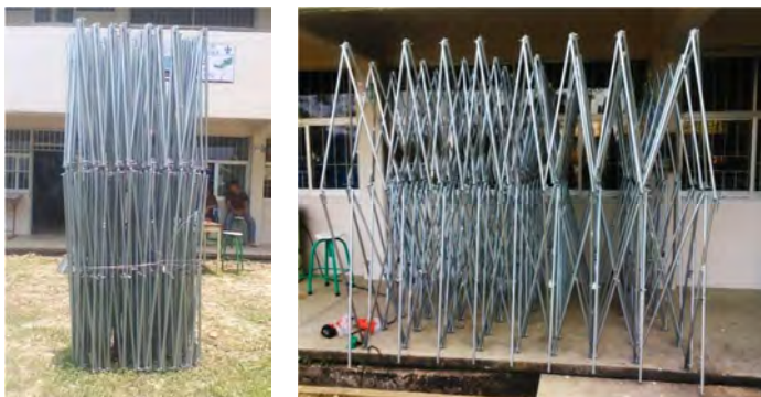
Figuras 17, 18. Una vez construido el paquete de aspas, se realizara el despliegado de la estructura en el sitio para comprobar sus despliegado y plegado de la cubierta transformable. Fuente: Morales 2015.
