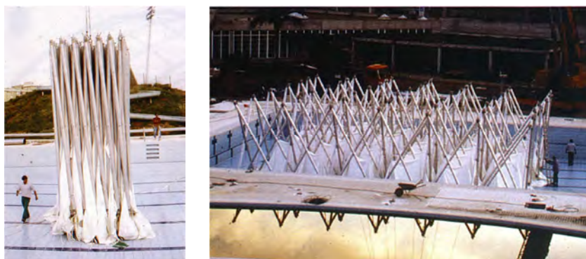
Figura 12, 13. Esquema de Izaje de una estructura plegable, podemos observar cómo será el proceso constructivos de nuestra estructura ya armada con todas las conexiones y accesorios, al igual que este sistema se alzara con una grúa. Fuente: Escrig & Sánchez, 1999.
