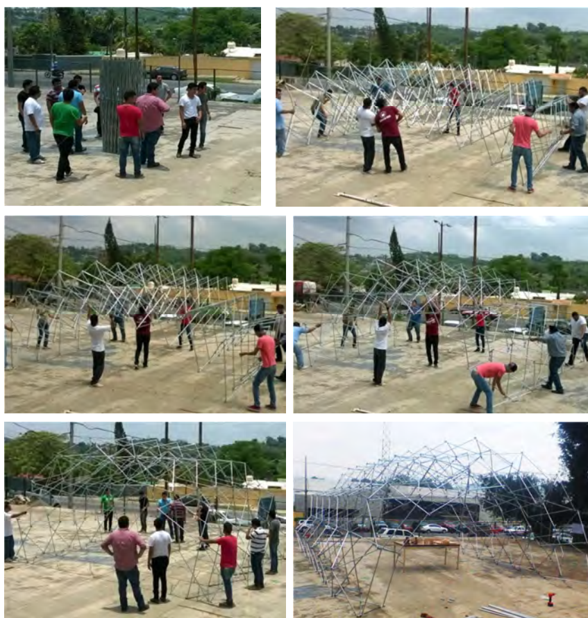
Figuras 19-24. El proceso de alzado ayuda a determinar cómo se comportaría el modelo en la construcción y como serían sus deformaciones en algunas partes de la cubierta, también se comprobó que se puede unificar el sistema transformable, ya que anteriormente está separada por la cubierta plegable y la geodésica como dos sistemas independientes, con esta práctica determinamos que pueden estar unidas. Fuente: Morales 2015.
