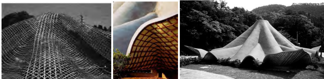
Figure 8. Proyecto de Yoh empleando una formaleta de malla en bambú combinada con una membrana para la cubierta del Centro Comunitario y guardería en Naiju; fotos ARCPROPECT
