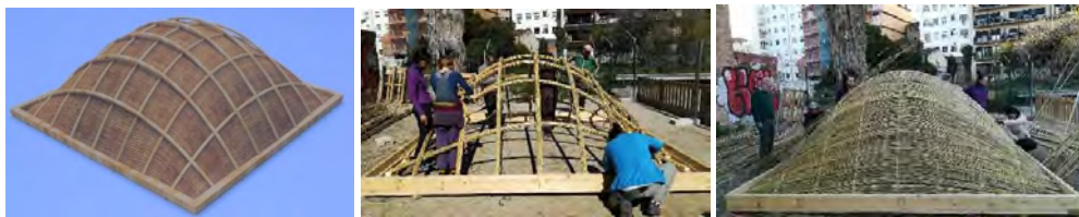
Fig. 9. Diseño de una cubierta de sombra para un parque infantil en Barcelona por Investigació Canyera, Volta Arquitectos y Can Batlló, fotos por Investigació Canyera.
