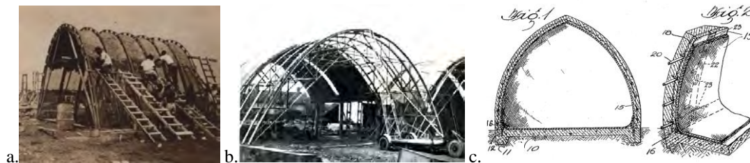
Figure 2. a. & b. El Sistema Ctesiphon de Waller & Aston; fotos del Archivo Irish Architectural (álbum Waller) c. Bocetos de Neff detallando el sistema balloon-house ; imagen de [7]
