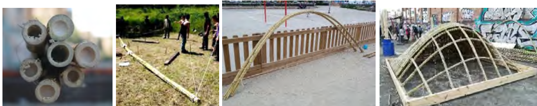
Fig. 7. a. / b. Proceso de doblado activo de un arco con el método Canya Viva; fotos por el autor e Investigació Canyera
