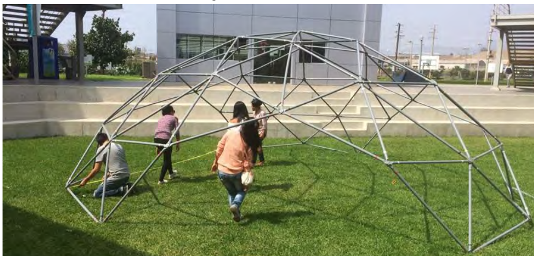
Figura N°15: Estudiantes de la carrera de Arquitectura y Urbanismo Ambiental de la facultad de Ciencias Ambientales de la Universidad Científica del Sur construyendo una estructura geodésica dodecaédrica de frecuencia dos fabricada con tubos de PVC.
