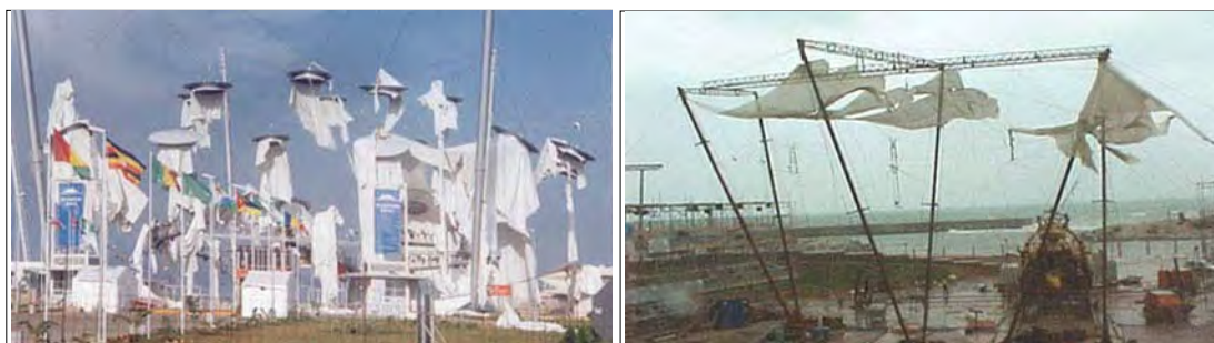
Figuras 16 y 17: El viento ha desgarrado la membrana pero los mástiles siguen en pie.
