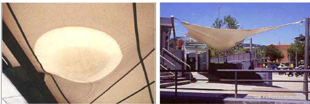
Figuras 12 y 13: Los encharcamientos progresivos invierten la curvatura.
