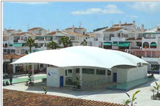
Figura 10: Ch.García-Diego, J.Llorens & H.Pöppinghaus, 2007: Cubierta del acuario de Almuñécar (TensiNews, nº 13, p.9).
