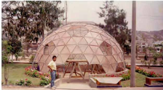
El Domo Geodésico DG, se proyectó de frecuencia 6, con un radio de 4.00 m., sobre una base cilíndrica de concreto de 0.70 m. de altura y 0.40 m. de grosor, logrando una altura final de 4.70 m.
