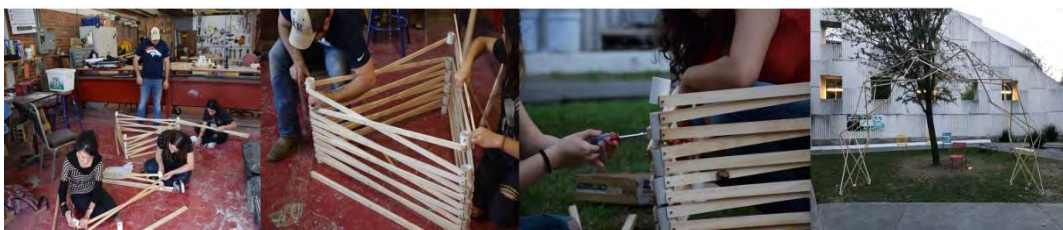
Figura 9: Construcción de los arcos despleables.
