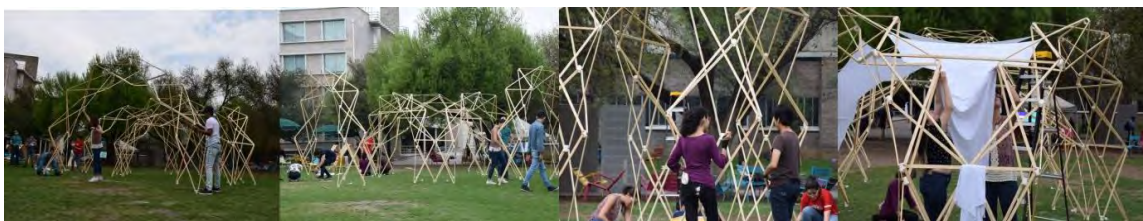
Figura 11: Montaje del Pabellón Vertex con arcos desplegables y cubierta tipo lycra.
