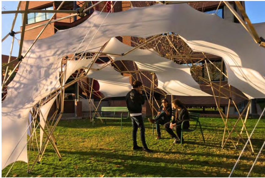
Figura 5: Pabellón Torus4. Experiencia previa con arcos desplegables, construida en la UIC. Barcelona.
