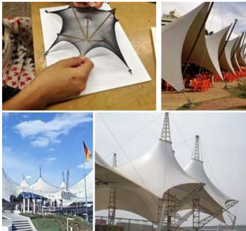
Figura 10: Composición fotográfica que muestra cómo un estudiante experimenta los esfuerzos de tensión en un modelo a escala. Con postes se obtienen las alturas necesarias y con cables se logra la estabilidad del sistema. A continuación fotos de estructuras reales. En algunos casos los postes pasan a ser estructuras tipo cerchas o armaduras, debido a la intensidad de los esfuerzos que soportan.
