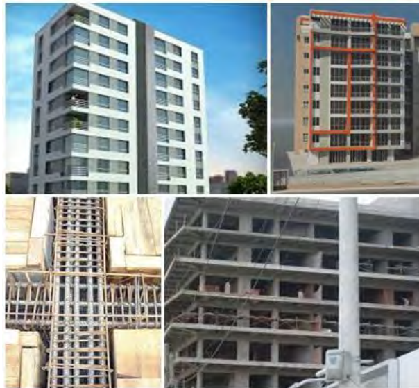
Figura 1: Composición fotográfica de edificios con pórticos de concreto armado que muestran columnas, vigas y losas con gran cantidad de concreto y acero, los que limitan la arquitectura a formas ortogonales que resultan pesadas y riesgosas en un país sísmico como el nuestro.
