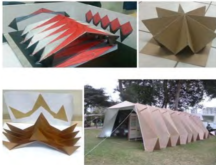
Figura 4: Composición fotográfica de proyectos académicos de plegaduras en maquetas presentadas junto con las elevaciones laterales y frontales, la imagen final es un recinto temporal de exposiciones en base a plegados en cartón corrugado grueso, instalado en una feria ecológica en Barranco, Lima
