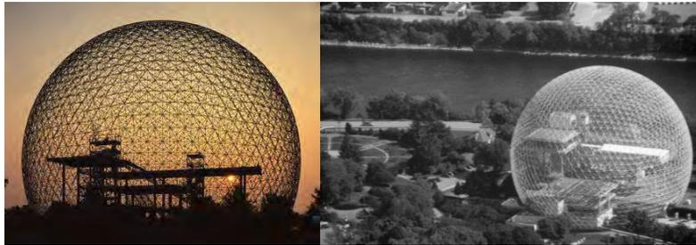
Figura 2: Biosfera de Montreal Expo Mundial 1967, diámetro de 76 m., 41.5 de altura y pesó 53 kg/m<sup>2</sup>.
